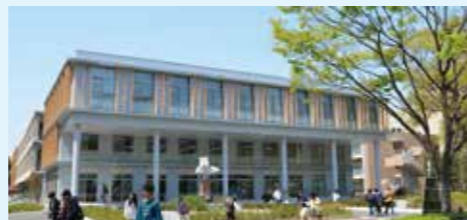
写真: 埼玉大学図書館外観
