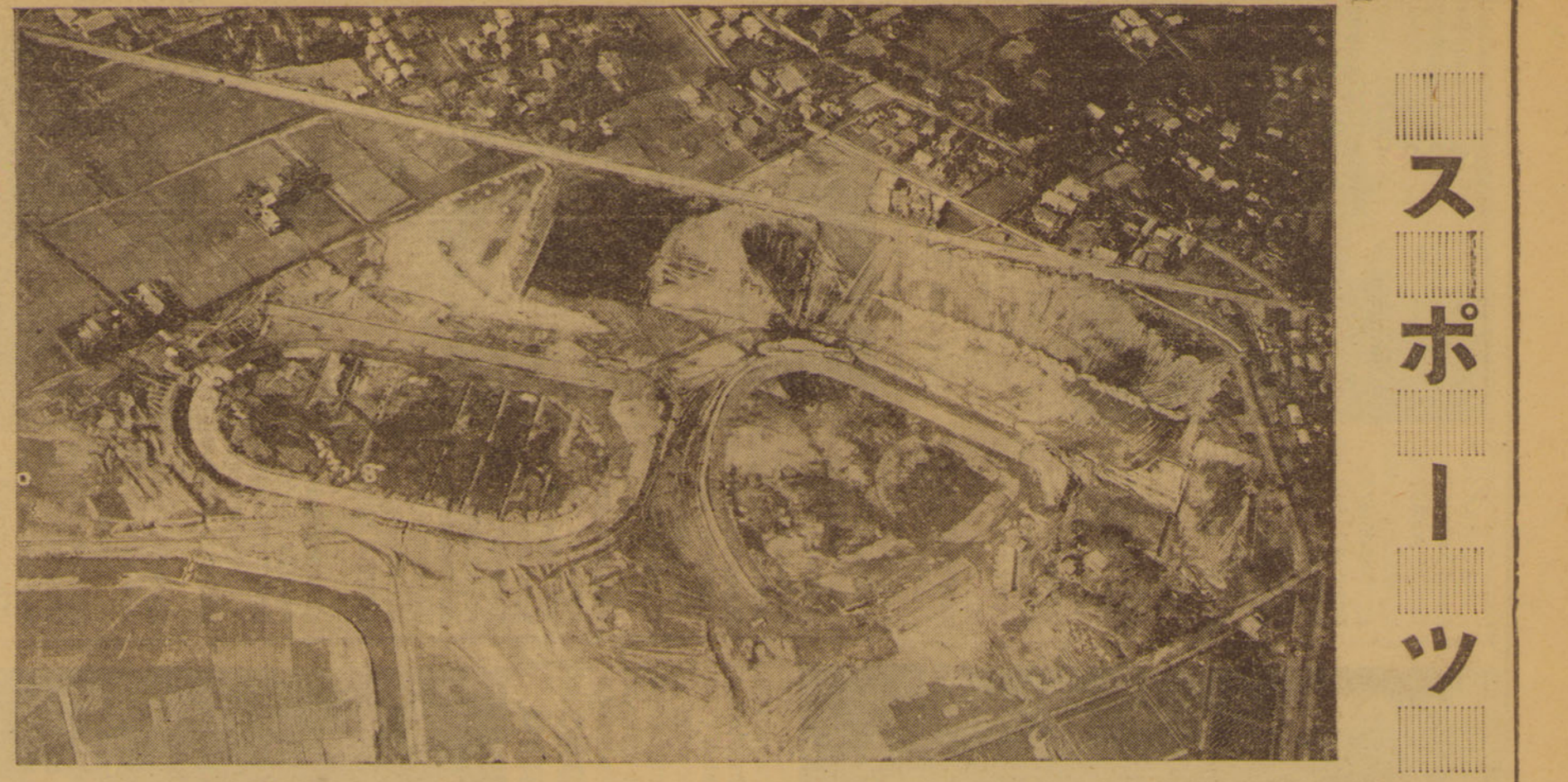
完成迫る総合グラウンド 本学総合グラウンドは上板橋に五万坪を占める日本一のもので、昨年十一月三日に假入式が行われ、第一期工事も去る四月十六日に終った。目下第二期工事を進めている。今秋の学院運動会はおそらくここで開催されるだろう。
