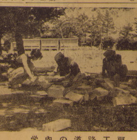
学内の道路工事
